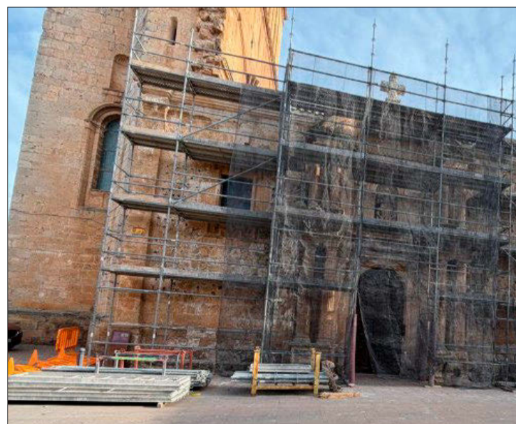
Iglesia de Vadocondes en plena restauración. ARZOBISPADO DE BURGOS
